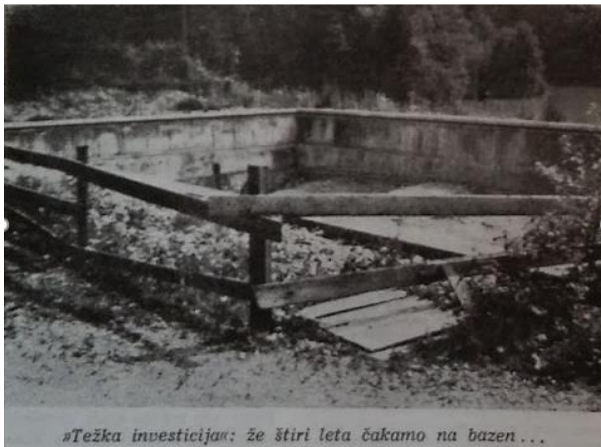
Slika 18: Izkopana luknja za bazen. (Vir Informacije Elektrokovina letnik 1968)
