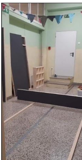
SLIKA 7: Montaža predelnih sten; lasten arhiv
