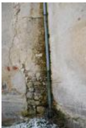
Slika 23: Uničena fasada, ki razkriva način gradnje. (Lasten vir.)
