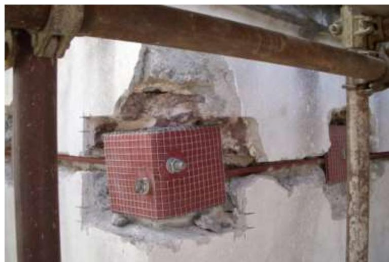
Slika 51: Primer vgraditve protipotresnih elementov v star objekt
