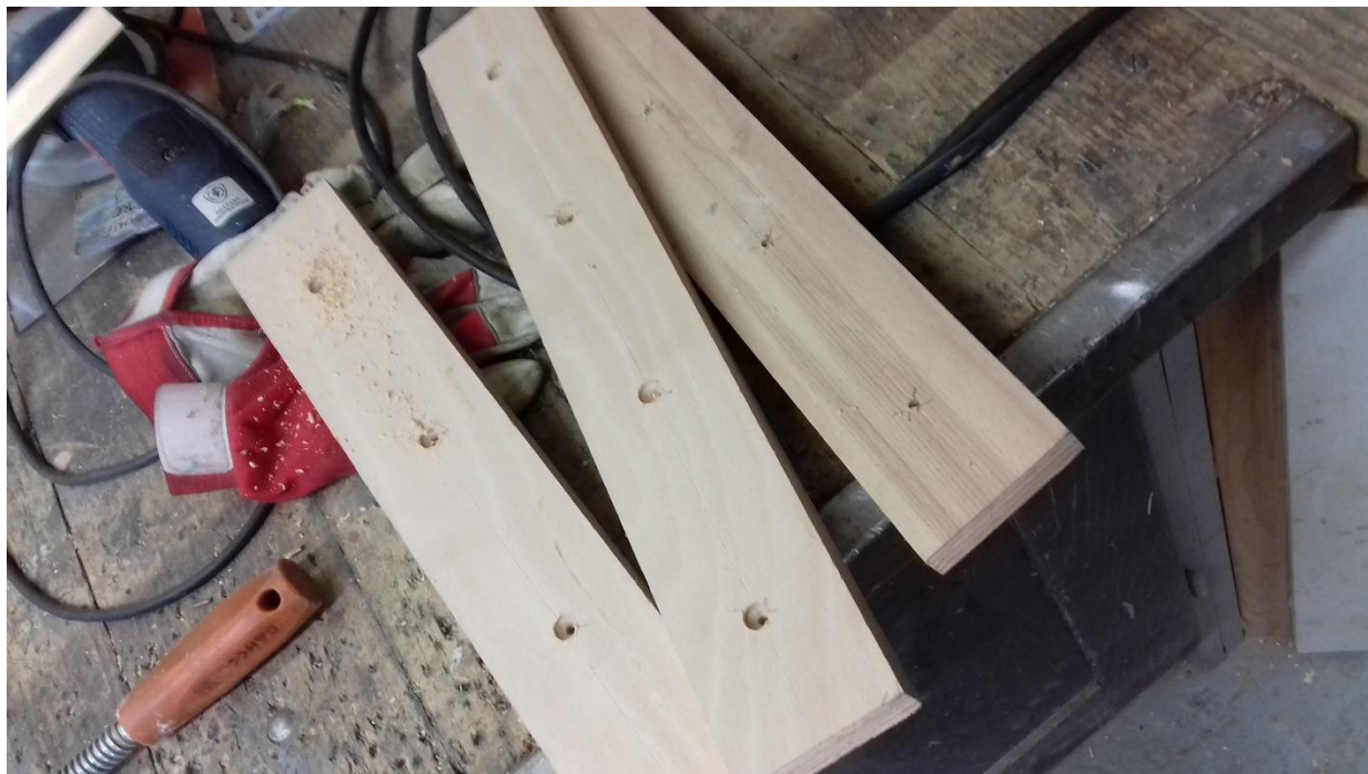
Slika 4: Izdelava desk iz vezane plošče za stabilizacijo šablone (vir: lasten)
