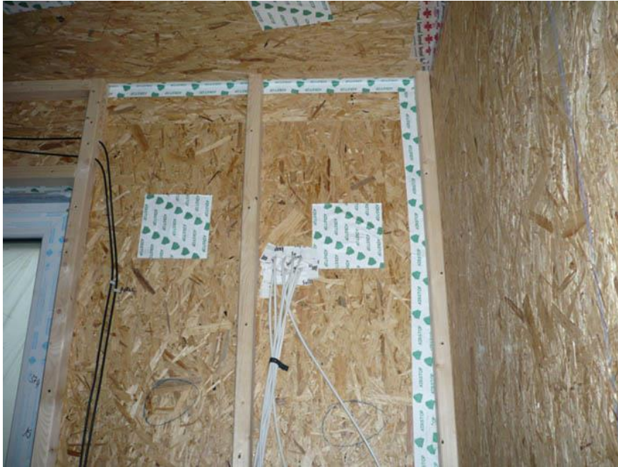
Slika 7: Tesnenje pasivne hiše
