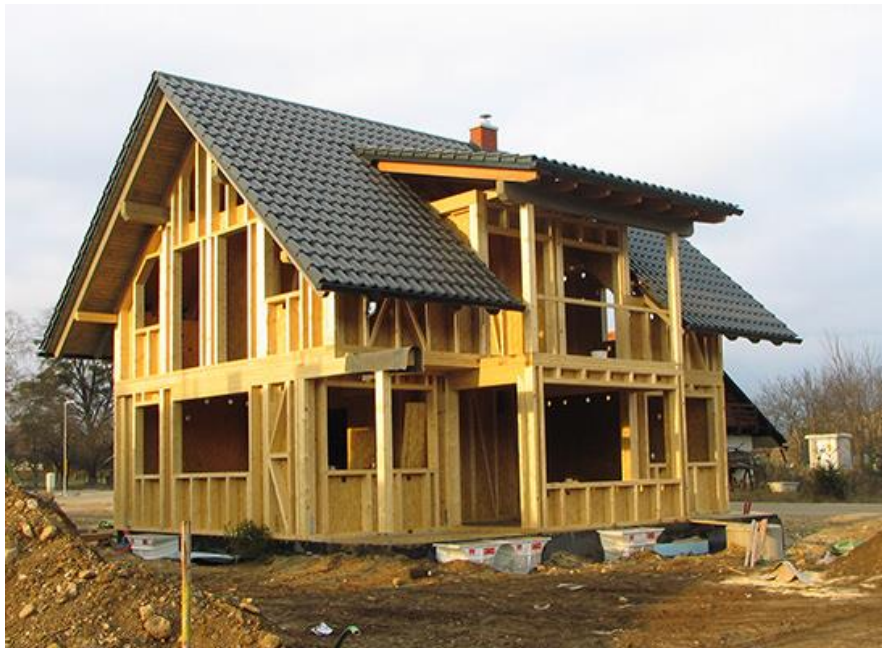
Slika 11: Primer skeletne gradnje
