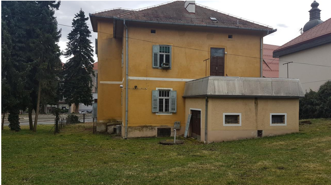
Slika 30. Stavba stare lekarne – zadnja stran, Ormož. 10. januar 2020
