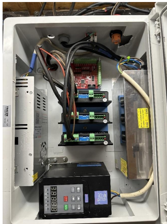
Slika 19: Komponente povezane v električni omarici
