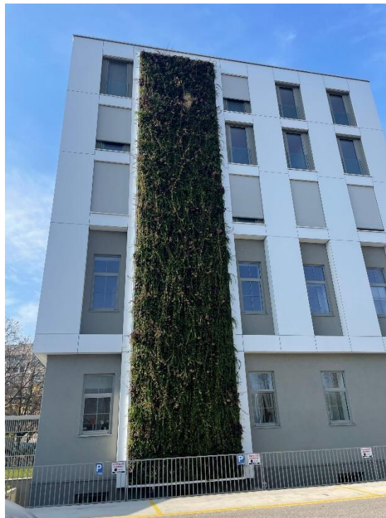
Slika 6: Zelena stena na stavbi v Ljubljani
