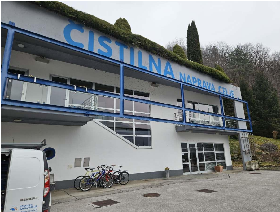
Slika 3: Čistilna naprava Celje [6]
