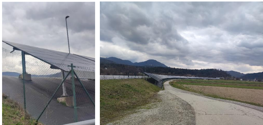
Sliki 21 in 22: Betonski temelji na strmem terenu – HE VRHOVO (lastni vir)
