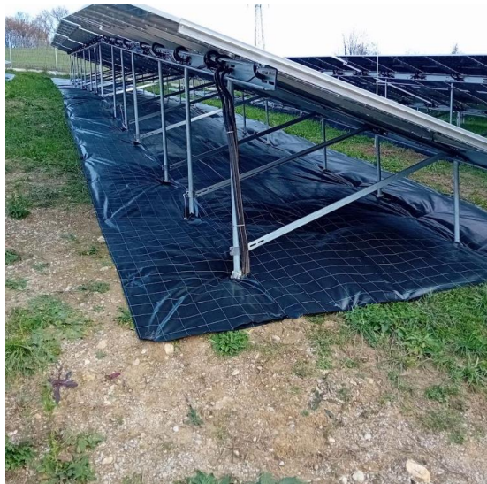
Slika 18: Nosilna konstrukcija, pritrjena v vijak (lastni vir)
