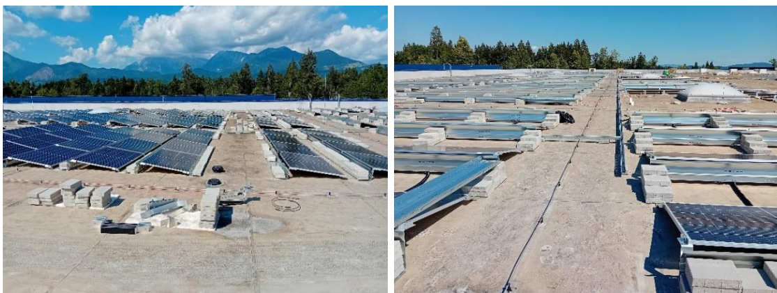
Sliki 10 in 11: Sončne elektrarne z žagastim nameščanjem (lastni vir)
