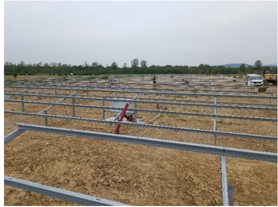
Sliki 26 in 27: Zabijanje temeljev, podkonstrukcija na zabitih temeljih (lastni vir)
