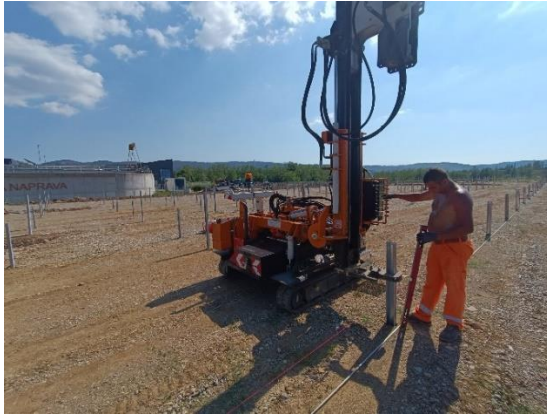
Sliki 26 in 27: Zabijanje temeljev, podkonstrukcija na zabitih temeljih (lastni vir)
