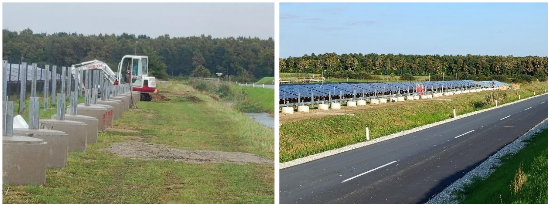
Slika 23 in 24: Betonski temelji za sončno elektrarno (lastni vir)
