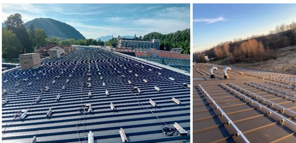
Sliki 6 in 7: Konstrukcija sončne elektrarne na pločevinasti kritini (lastni vir)
