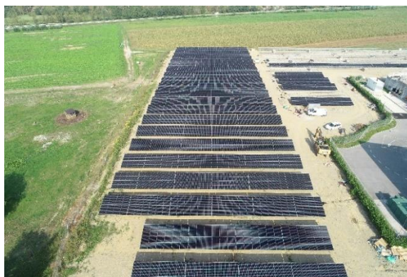
Slika 25: Sončna elektrarna na zabitih temeljih (lastni vir)
