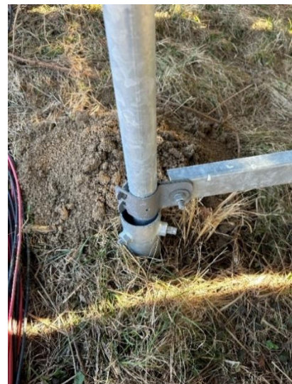
Sliki 19 in 20: Nosilna konstrukcija, pritrjena v vijak z detajlom (lastni vir)
