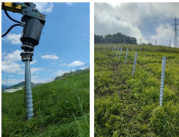
Sliki 14 in 15: Vijačenje vijakov za nosilno konstrukcijo sončne elektrarne (lastni vir)
