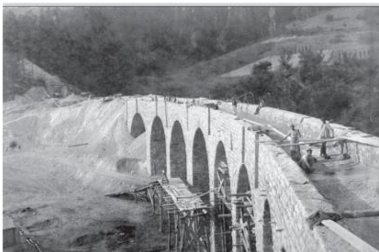
Slika 6: Gradnja viadukta v Doliču (vir: SI_KPM, Fototeka)
