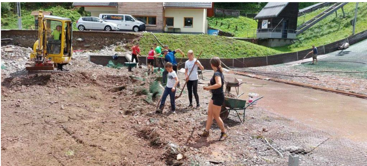
Slika 5: sanacija škode po poplavah avgusta 2023
