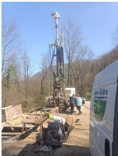
Slika 18: Gradnja globokega vodnjaka (Foto: Geo-Hidro)
