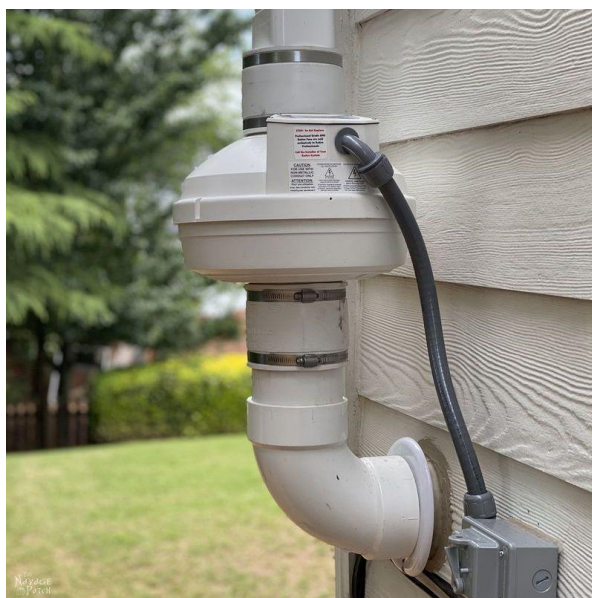
Slika 8: Ventilacijska metoda odvajanja radona pod tlakom
