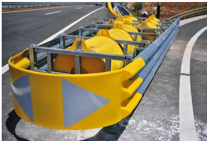
Slika 3: Blažilnik z zračnimi blazinami in kovinsko konstrukcijo ( vir ).
