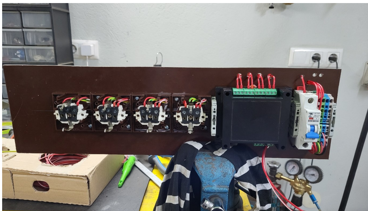
Slika 38: Inštalacija kablov v krmilnik.
