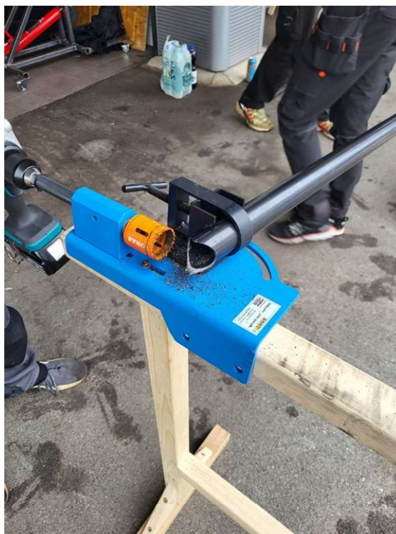
Slika 6.3: Priprava za oblikovanje zaključkov cevi z vrtalno krono.
