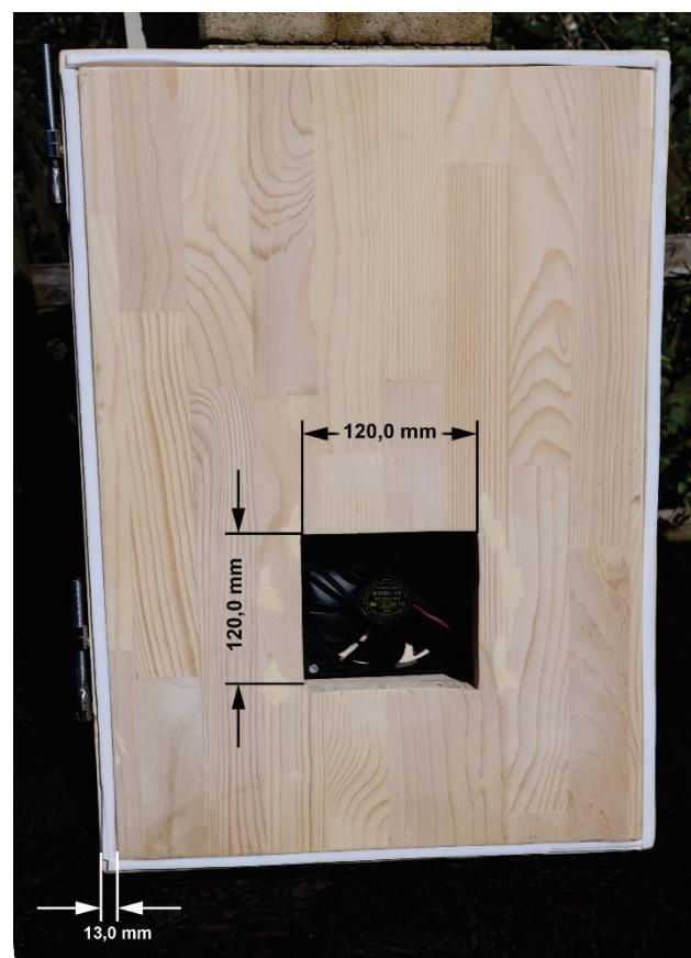
Slika 32: Notranja stran vratc z merami odprtine in roba
