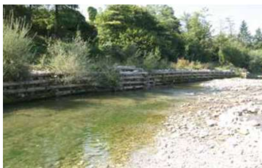
Slika 62: Zavarovanje z leseno kašo na Savinji (Foto: P. Repnik Mah, 2012) 104
