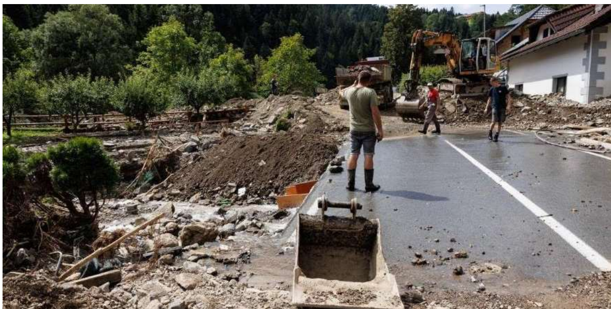
Slika 35: Začetek sanacije v Strugah 71
