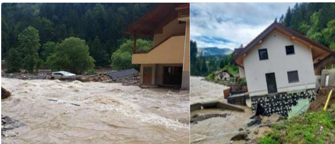
Slika 33: Poplave v Strugah 68
