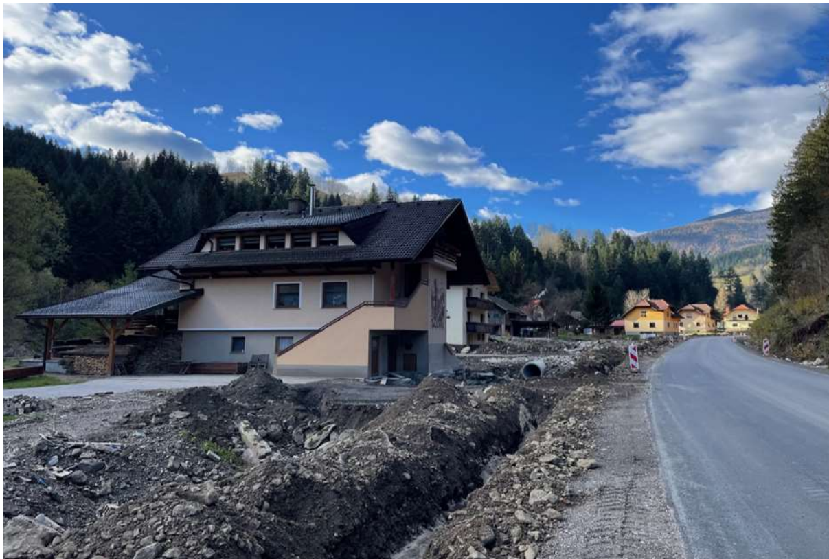
Slika 47: Odprava škode po poplavi 85
