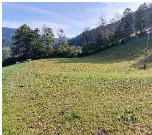
Slika 61: Zaledje plazu pod lokalno cesto (Jezernik) 100
