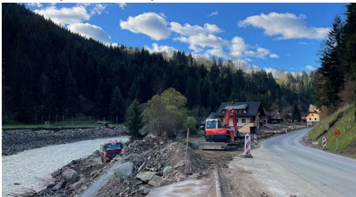
Slika 49: Gradbena dela v Strugah 87
