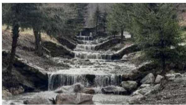
Slika 10: Pregrade za stabilizacijo 20
