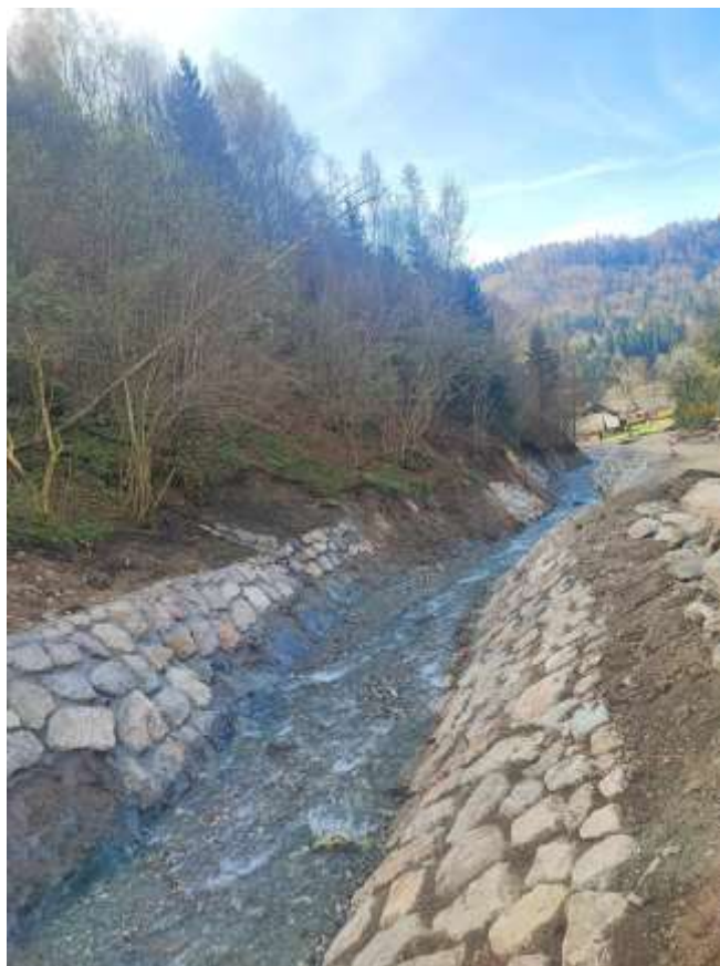
Slika 36: Regulirana struga Volovljeka (vir: Kaja Spruk)
