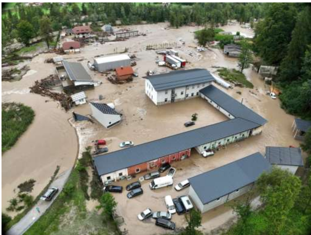
Slika 28: Zračni posnetek poplavljenega območja okoli Velikega jezua (vir: Medmrežje 19)
