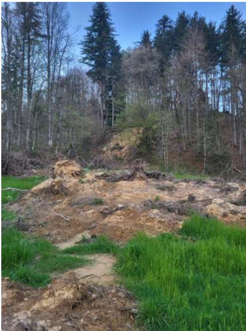
Slika 41: Zemeljski plaz v dolini potoka Tunjščice v Podgorju (Avtor: Miha Bogataj)
