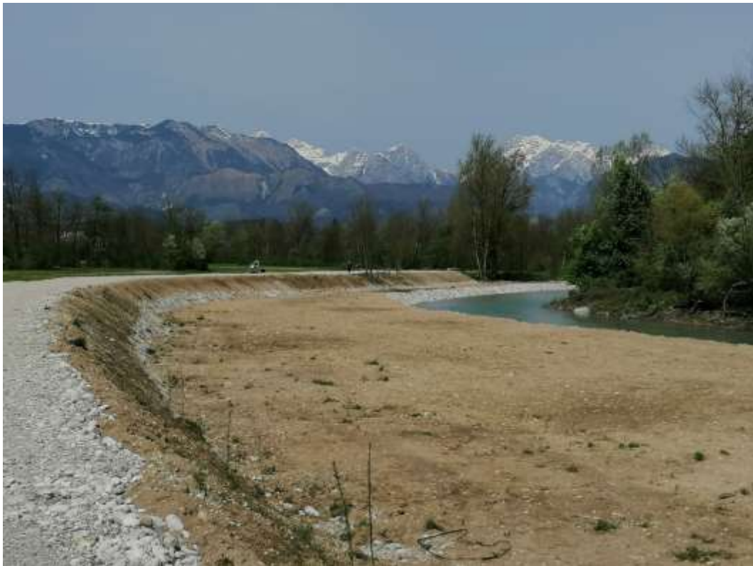
Slika 25: Nov protipoplavni nasip v Šmarci, april 2024 (Avtor: Veronika Tonin)
