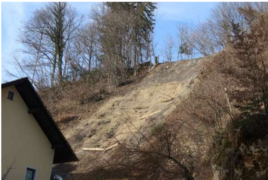
Slika 46: Saniran plaz v Županjih Njivah (Avtor: Manca Pristavec)
