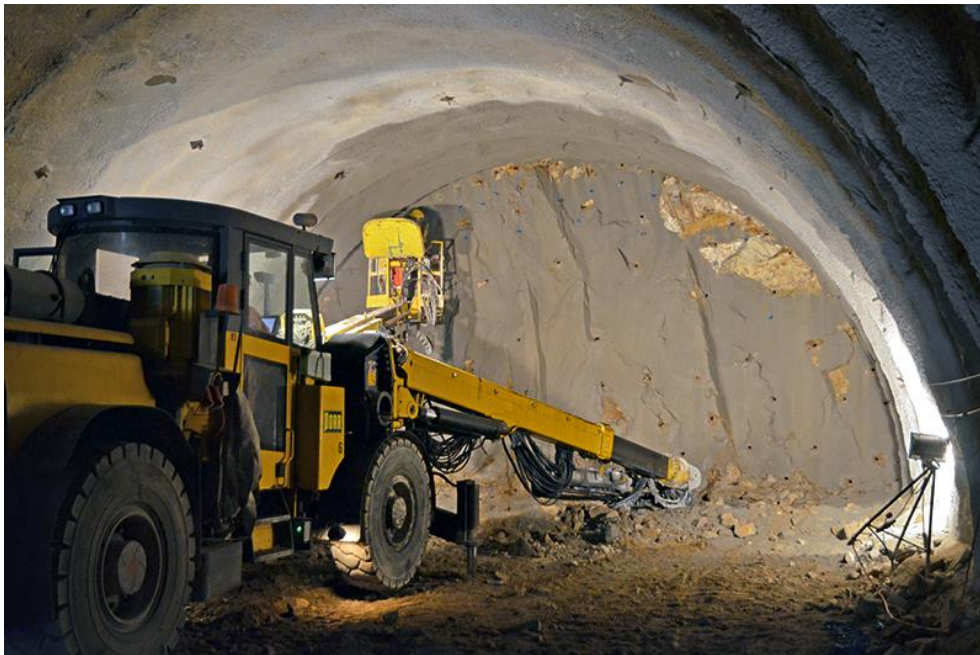
Slika 1. Izkop kalote predora po metodi NATM [3].
