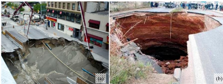
Slika 3. Posledice pogrezanja pri gradnji predorov v urbanih območjih [6].
