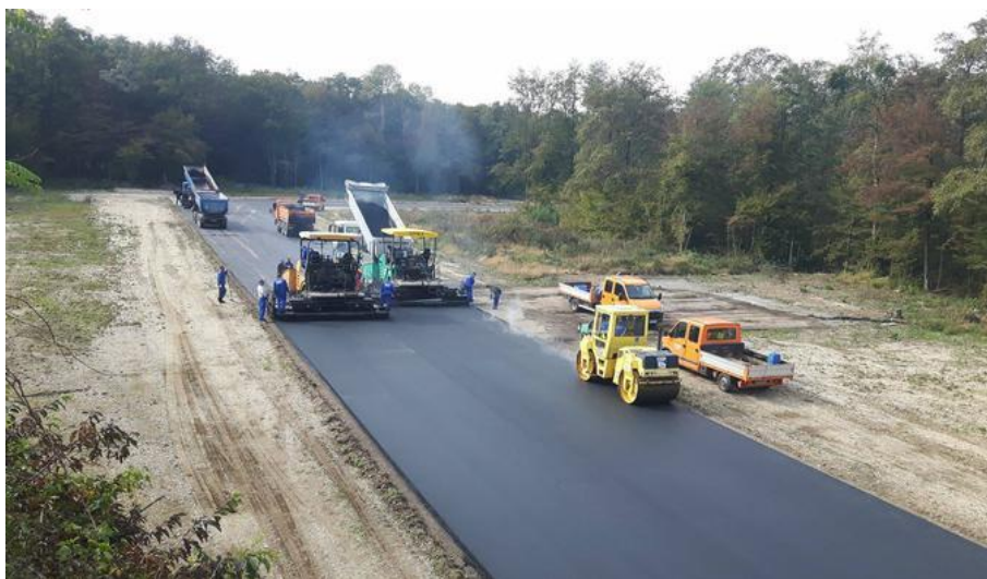
35 Obnavljanje asfaltne proge v Gaju na Dolenjskem.
