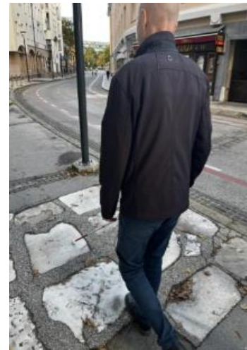
Slika 16: Graniten pod v mestnem centru. Vir: Lasten
