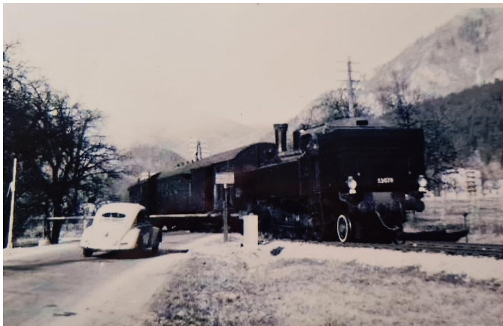
Slika 25: Cestna zapornica na koncu Retenj, kjer je danes križišče proti Pristavi.
