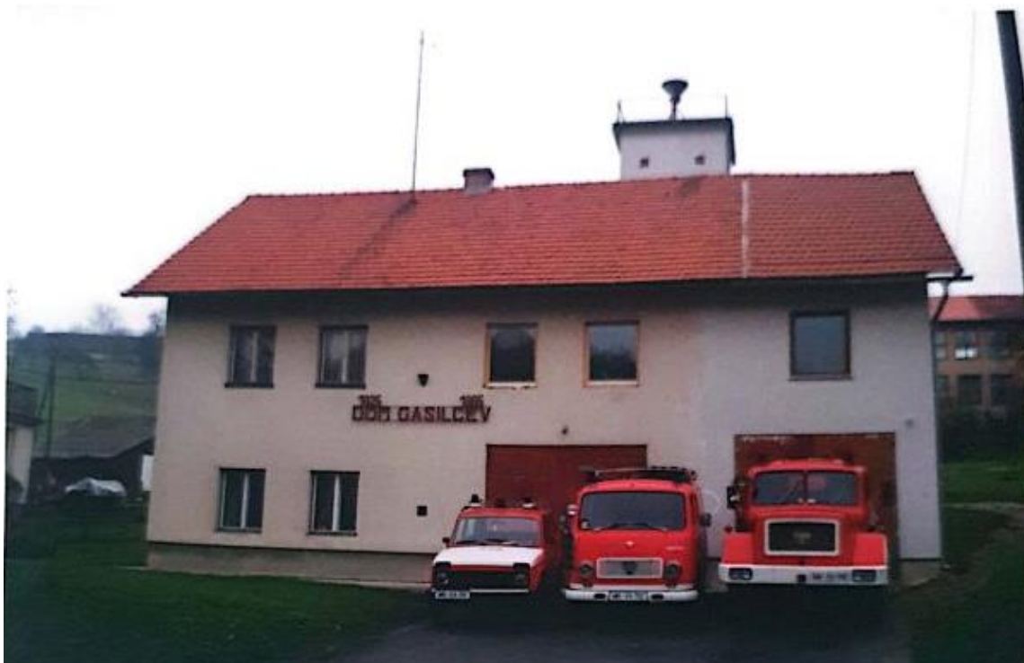
Slika 13: Dograditev gasilskega doma od 1987 do 1994. (APGD)
