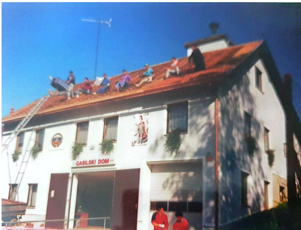
Slika 15: Obnova strehe gasilskega doma leta 1999. (APGD)
