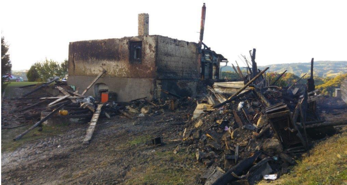
Slika 43: Posledice požara na stanovanjskem objektu. Posredovanje gasilcev. (APGD)
