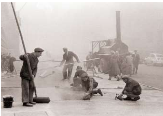
Slika 38: Asfaltiranje ceste v Mariboru 1959
