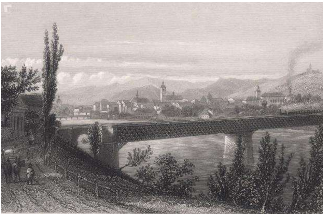
Slika 24: Prvi železniški, leseni most tipa HOWE čez Dravo v Mariboru, zgrajen leta 1846 (Vir: https://www.kamra.si/mm-elementi/leseni-most-tipa-howe-v-mariboru )
