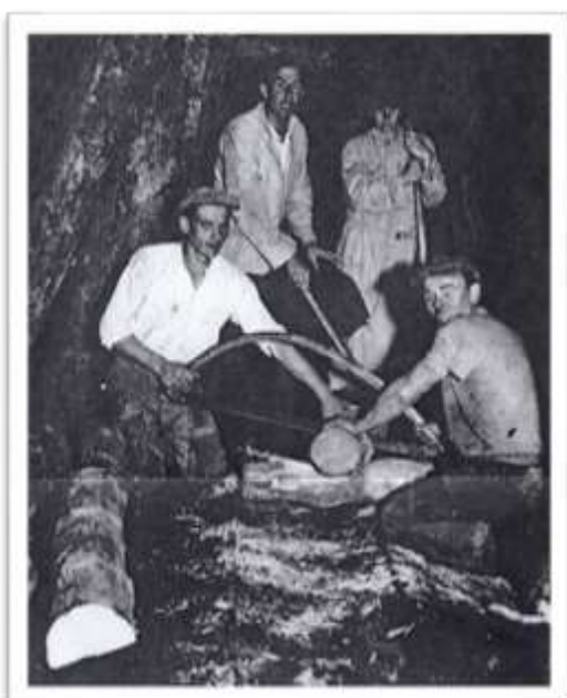
Slika 7: Dva rudarja vzdrževalca pri menjavi podpornika. Vir: Vinko Bobnič, 2012.
