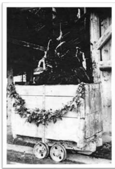
Slika 9: Rudniški voziček (hunt) nosilnosti 500 kg premoga. Vir: Vinko Bobnič, 2012.
