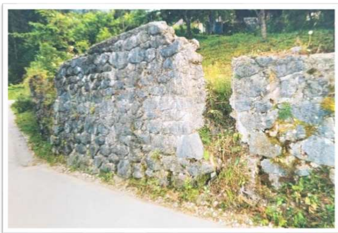
Slika 83: Podporni zid mostu, ki je vodil proti »šahtu« leta 2005. Lastnik fotografije: Jože Klinar.
