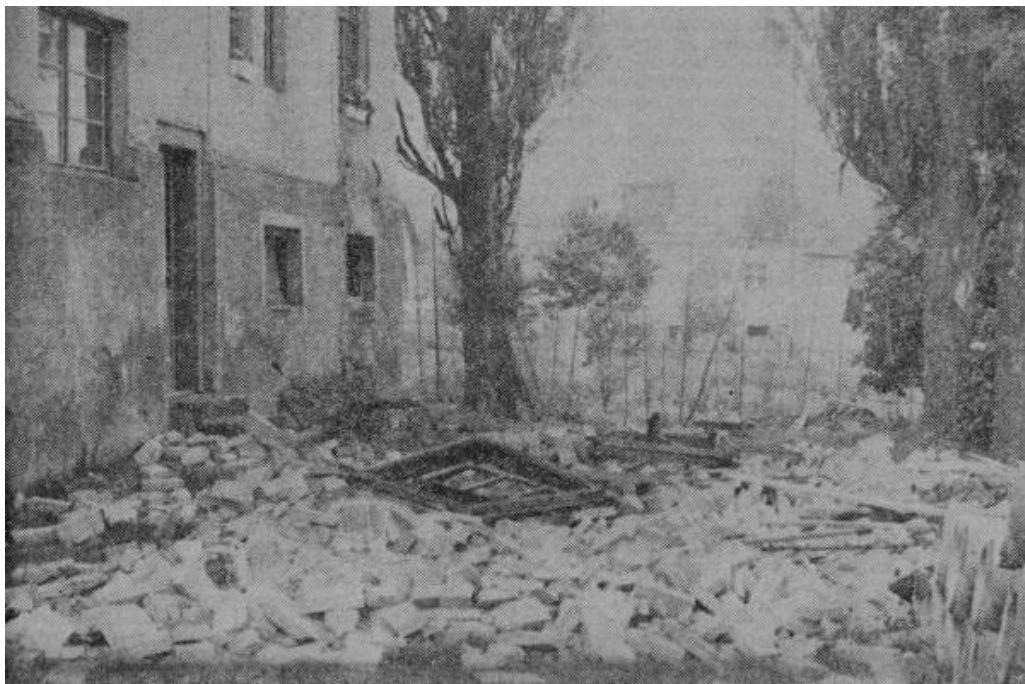
Slika 13: Bloku številka 24 v Šmarju pri Jelšah je odneslo kar celo steno tik pod slemenom strehe. Vir: Zemlja se je tresla. Novi tednik, št. 25, 27. 6. 1974, str. 1.
