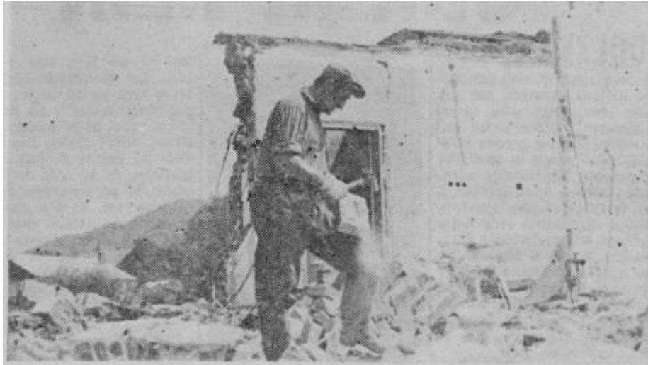
Slika 21: Delavec pri delu na gradbišču. Vir: Gradnja se je pričela. Novi tednik , št. 35, 5. 9. 1974, str. 3.
