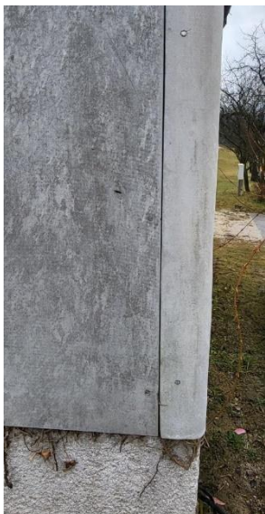
Slika 31: Vogal hiše, vijačenje panelov. Foto: Eva Rebernak, 2024.
