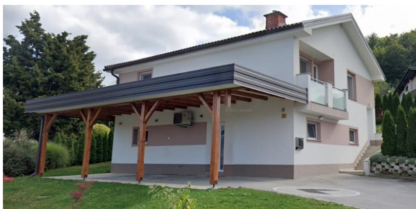
Slika 37: Montažna Marlesova hiša v Finžgarjevi ulici 3 je popolnoma obnovljena. Vir: Google Maps, 2024.
