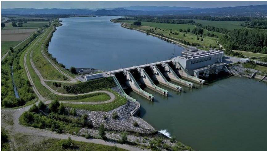
Slika 3: Hidroelektrarna Brežice z jezom na reki Savi
