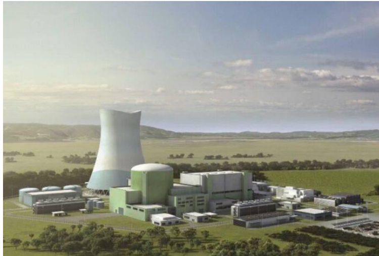
Slika 1: Jedrska elektrarna Krško
