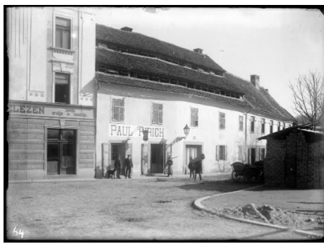
Slika 8: Pogled na Lesni trg. 9
