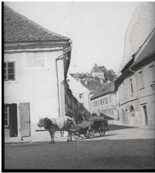
Slika 7: Pogled na Lesni trg. 8
