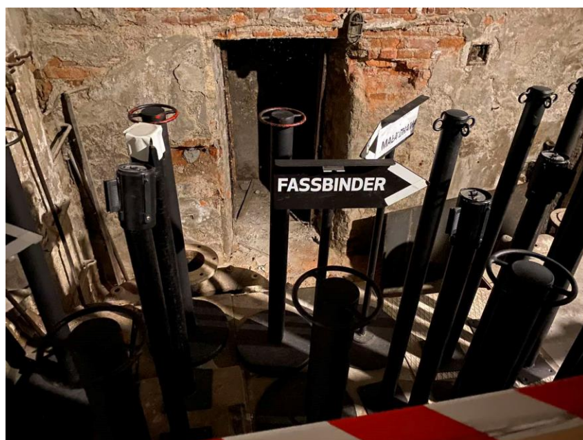
Slika 37: Bivša kotlovnica v kleti
