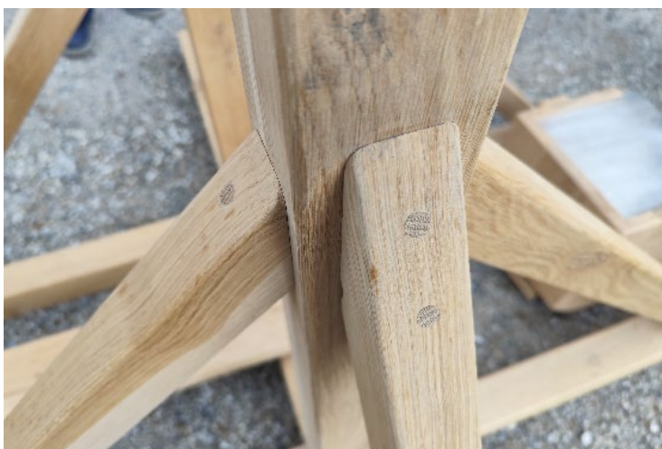
Slika 34: Lesni spoj z zamaskiranimi vijaki (levo) in kanal za namestitev izstrelka (desno).
