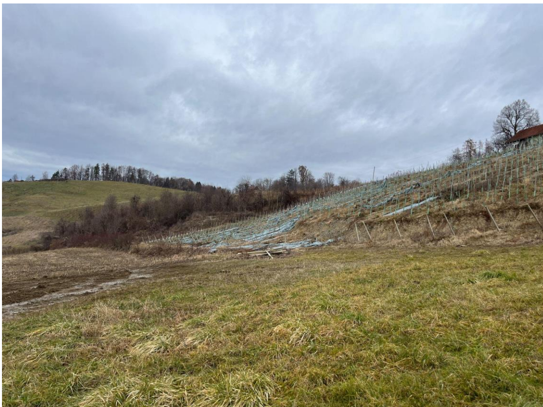
Fotografija 13: Območje plazov v novem nasadu vinograda na Pesjaku, od avgusta je novi nasad prekrit s foliji, da zaustavijo plazenje zemljin, Svečina, foto: Klara Stajenko, 21. 12. 2023.
