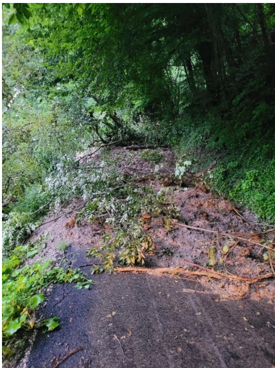
Fotografija 35: Drevje in blato na cesti do Šubernika na Vršniku, foto: občinska uprava Kungota, maj 2023.
