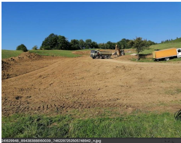
Fotografija 36: Zemeljska dela za sanacijo plazu na Ciringi, https://www.kungota.si/objava/563539 , dostopno 22. 12. 2023.
