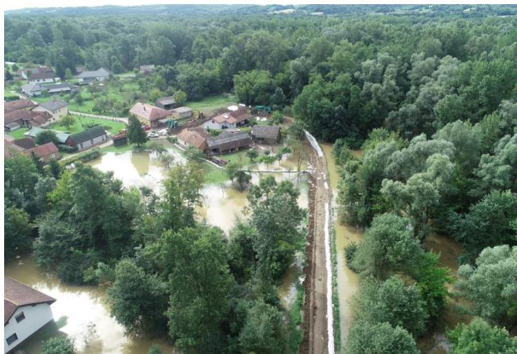
Slika 5: Poplavljanje Mure izven poškodovanega nasipa
