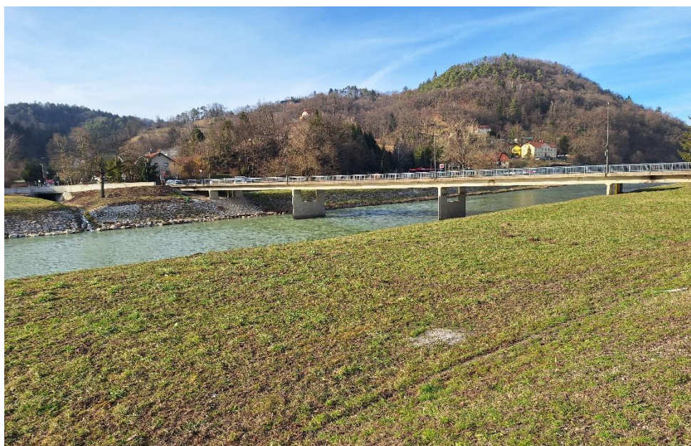
Slika 75: Most čez Savinjo s podporniki v strugi ( Dolžan , 2024)
