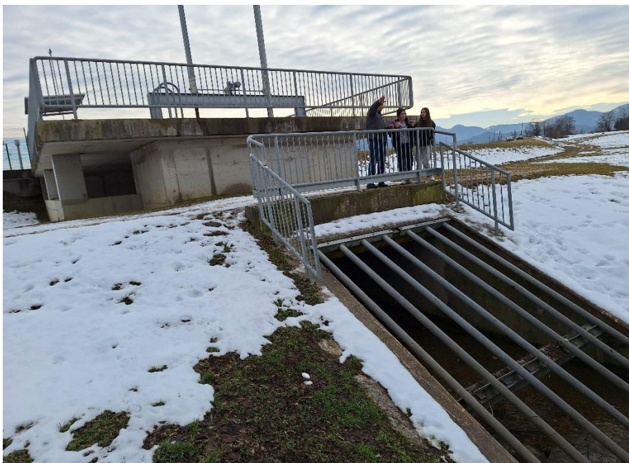
Slika 54: Grablje in zapornice na suhem zadrževalniku Sušnica - jug (Lukman, 2024)
