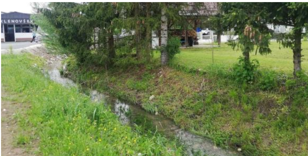
Slika 67: Lahovniški potok pod obstoječo premostitvijo (Hidrosvet, d. o. o., Projektna dokumentacija DGD, št. 40/22, 12)
