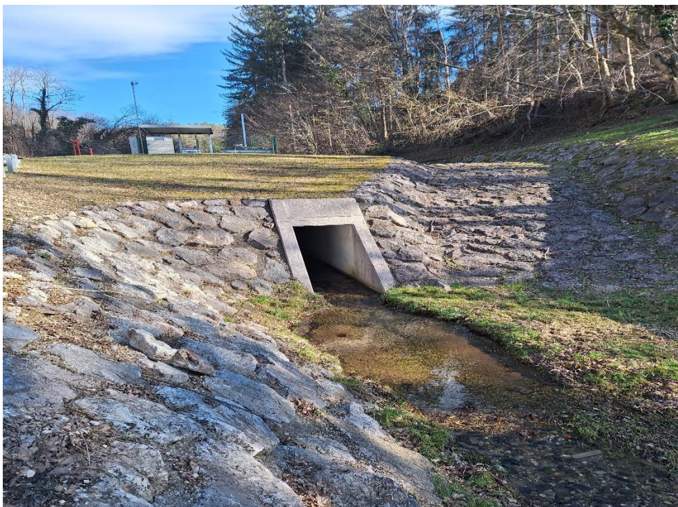
Slika 57: Iztok in bočni prelivni prostor ob suhem zadrževalniku Tomaž 2 (Golob, 2024)
