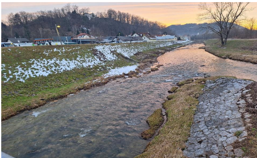
Slika 56: Protipoplavni nasip ob sotočju Voglajne in Hudinje (Dolžan, 2024)
