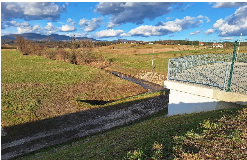
Slika 58: Vtok Vzhodne Ložnice pod zapornice suhega zadrževalnika Ljubečna in poplavni prostor za pregrado (Komadina, 2024)
