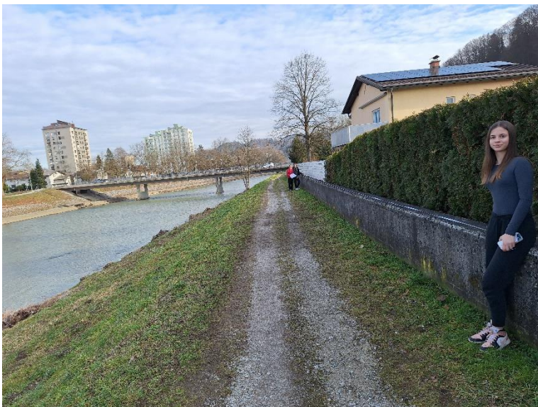
Slika 1: Meritve protipoplavnega betonskega zidu ob naselju Lisce (Golob, 2024)
