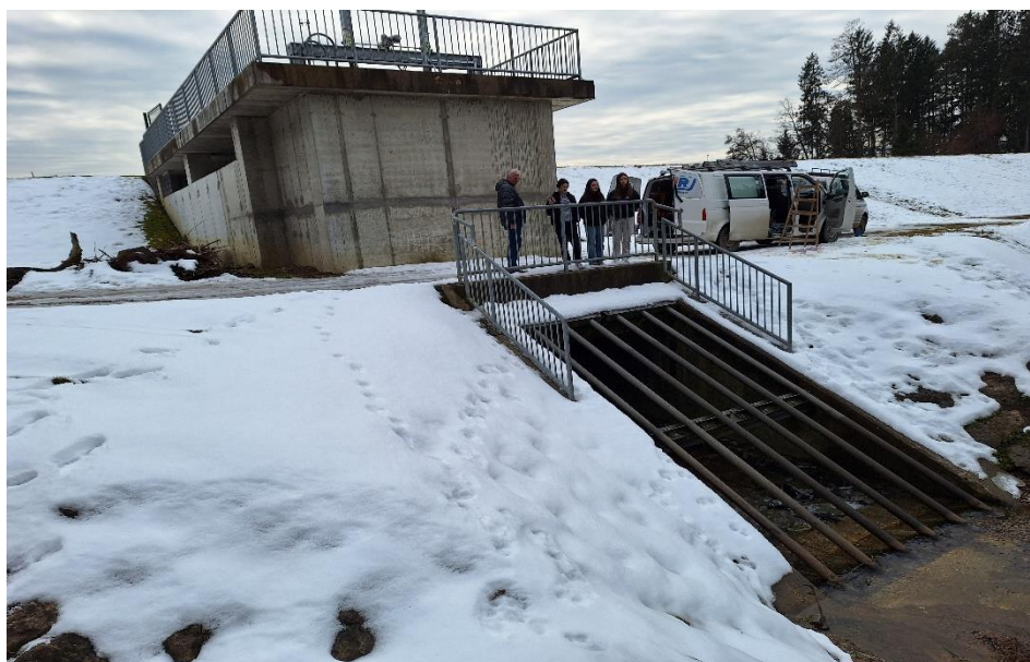
Slika 55: Nasip in objekt z zapornicami na suhem zadrževalniku Podsevčnica (Lukman, 2024)
