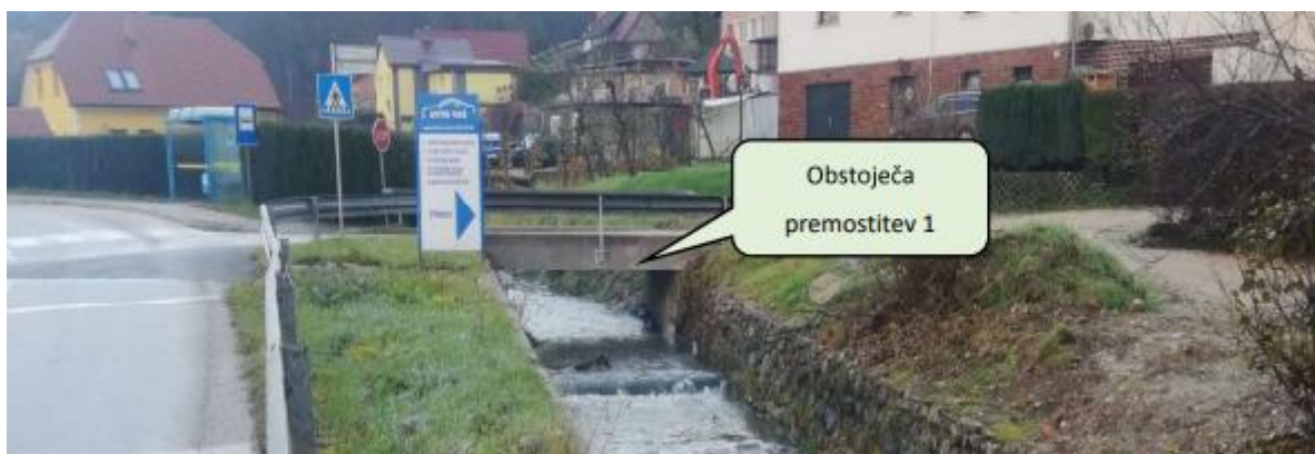
Slika 62: Premostitev 1 na Ločnici in videz pretočnega profila ( Projektna dokumentacija DGD, št. 39/22, 13 )
