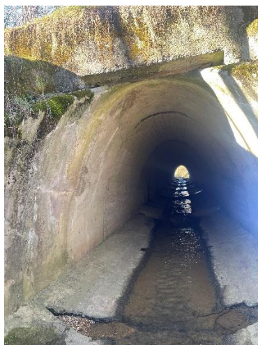
Slika 39: Tunel za Kostanjevico iz leta 1923 (Rauter, 2024)
