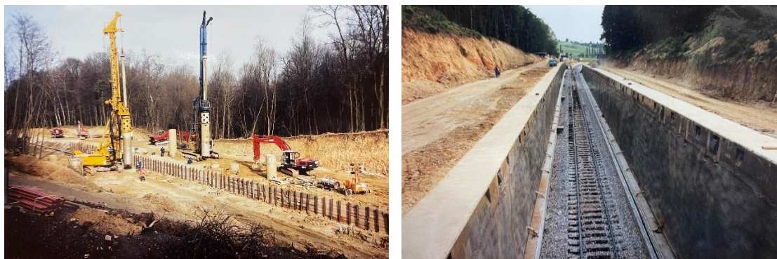
Slika 12: Rekonstrukcija proge žerovinskega klanca 2001, ukop v Mekotnjaku (Vir: Pomurski muzej, foto: Rustja, 2001)
