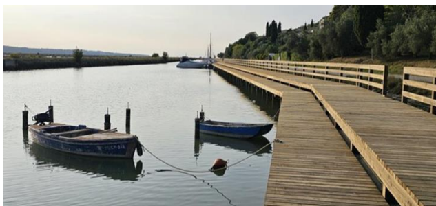
Slika 61: Urejeni mostovž v Jernejevem kanalu
