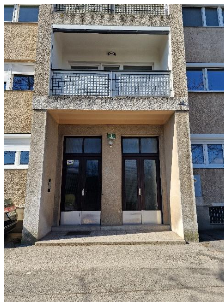
Slika 15: Primer neprenovljenih vrat.
