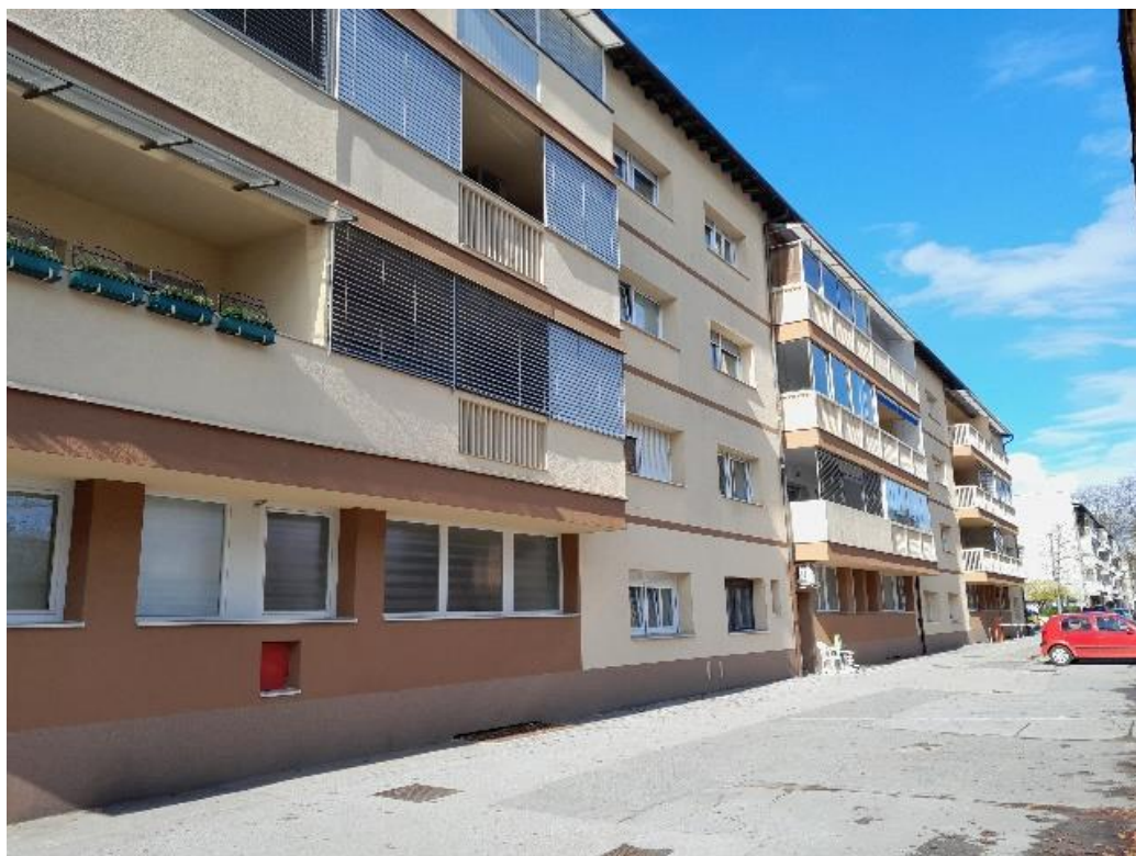
Slika 11: Primer obnovljene fasade.
