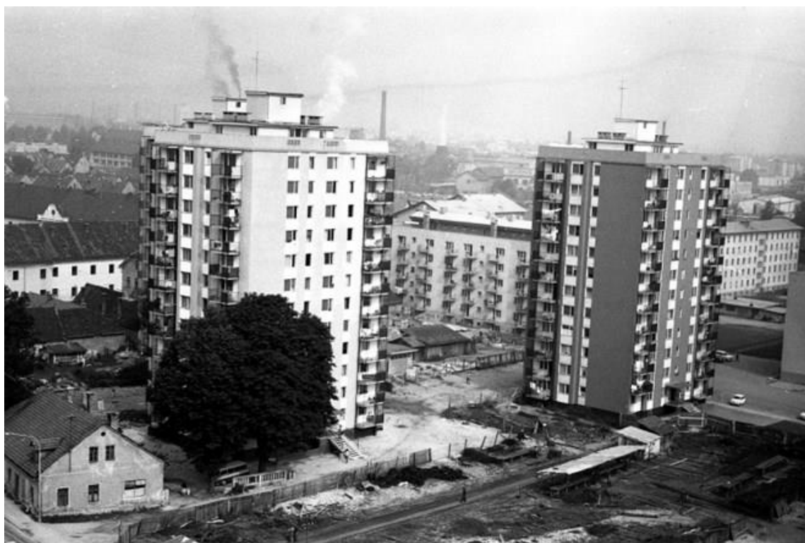
Slika 4: Gradnja blokov v Mostah.
