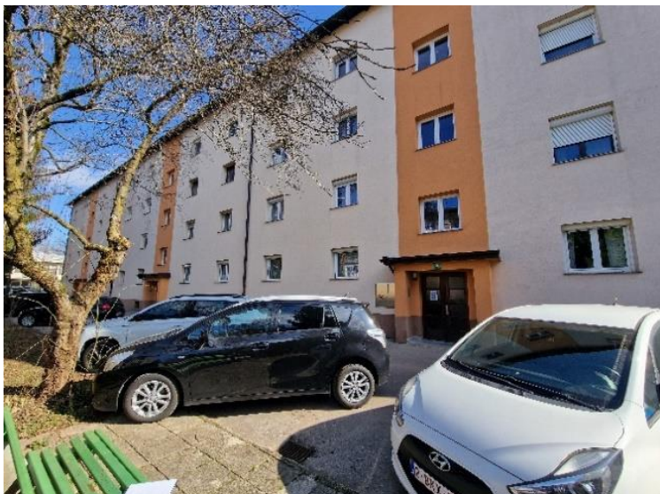
Slika 13: Primer obnovljene fasade.
