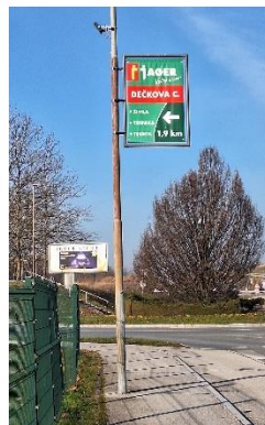
Obešanke na drogovih javne razsvetljave, montirane na višini najmanj 4,5 m. (14. čl.) (Podjavorškova ulica)
