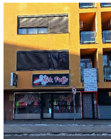
Agresiven poseg v pročelje stanovanjske zgradbe (Ljubljanska cesta)
