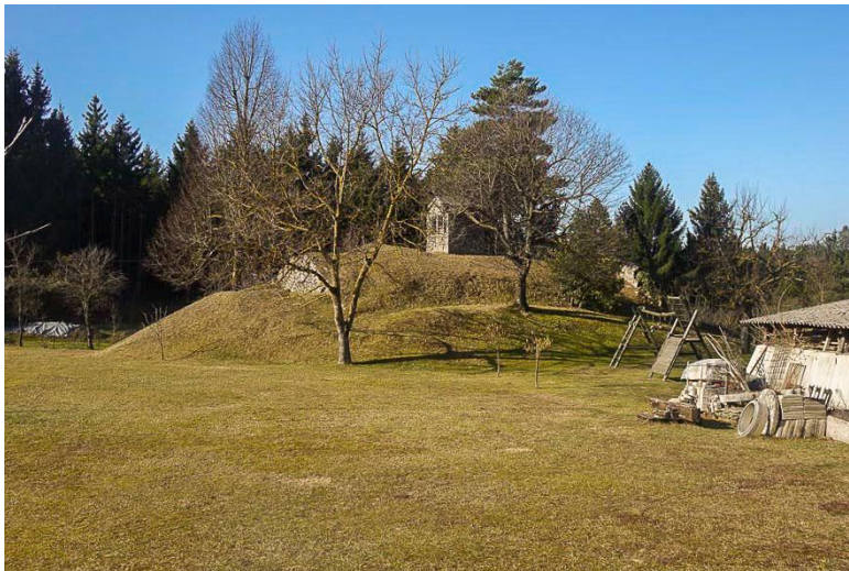
Slika 35: Vodni zbiralnik Rakek – rezervoar, 3. objekt železniškega vodovoda – danes (Perko 2022)
