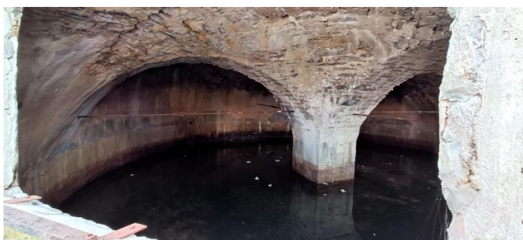
Slika 38: Notranjost vodohrana – danes (Vir: lasten)
