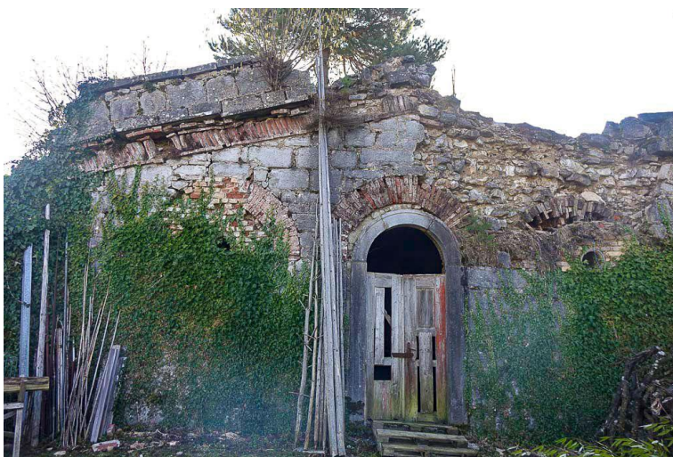
Slika 34: Vodni zbiralnik Rakek – rezervoar, 3. objekt železniškega vodovoda – danes (Perko 2022)
