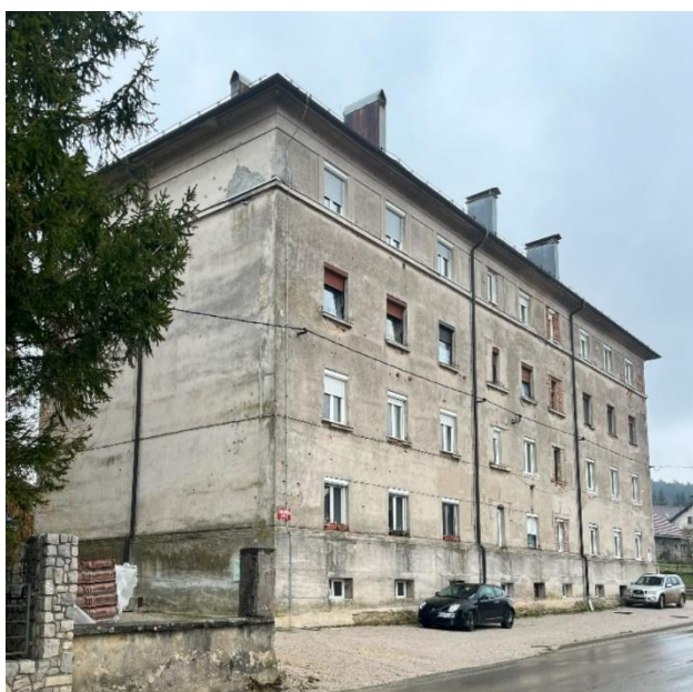
Slika 11: Železniška stanovanjska hiša – danes (Vir: lasten)
