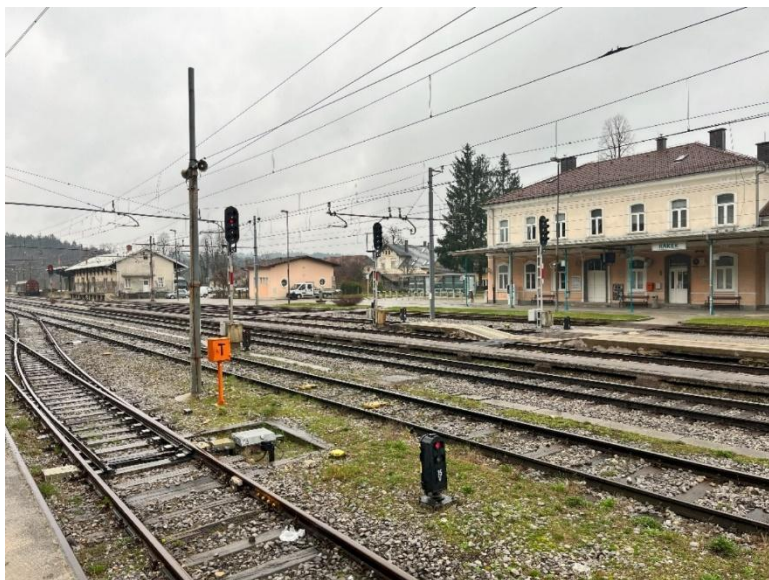
Slika 32: Železniška postaja – danes (Vir: lasten)
