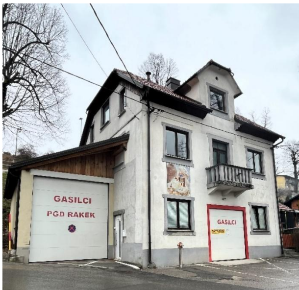
Slika 16: Stari gasilski dom – danes (Vir: lasten)
