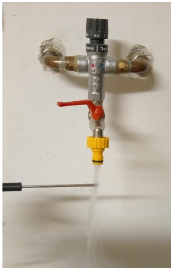
Slika 12: Izvajanje poskusa na pravem mešalnem ventilu (Rap, 2023)
