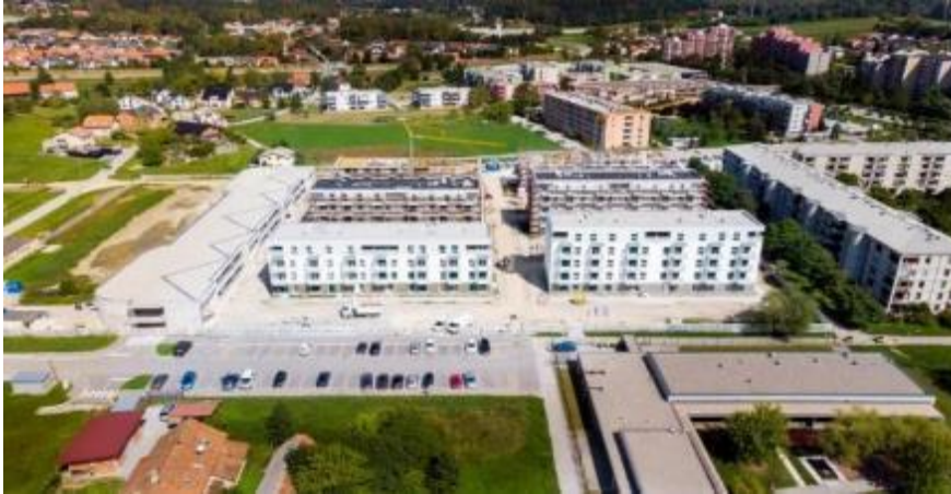
Slika 67: Gradnja stanovanjskih blokov v Dečkovem naselju 93
