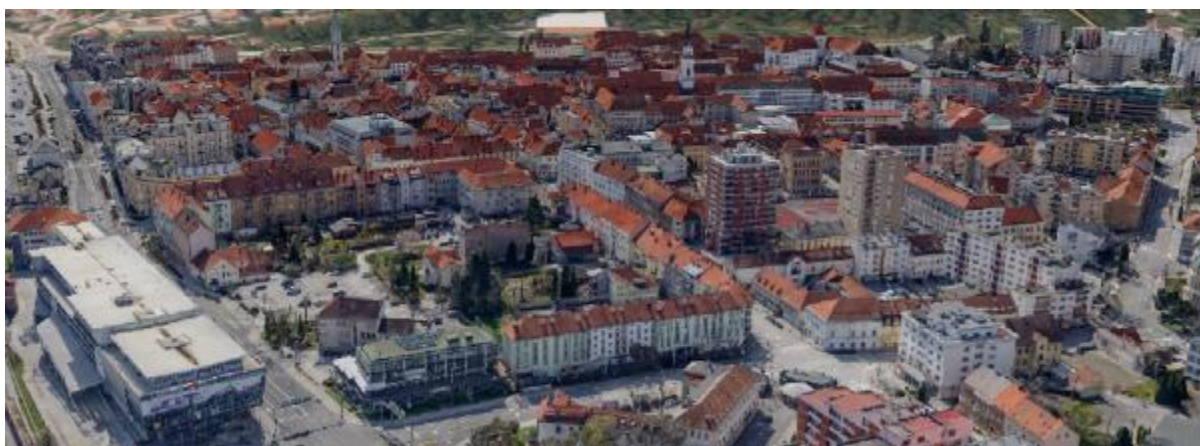
Slika 7: Pogled s severa na novejša poslopja MČ Center 15
