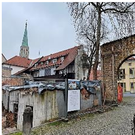
Slika 41: Porušena hiša na Razlagovi čaka na celovito prenovo 66
