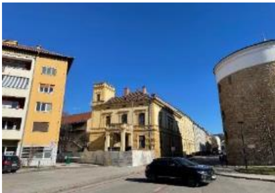
Slika 32: Prenova stavbe na Vodnikovi ulici 57
