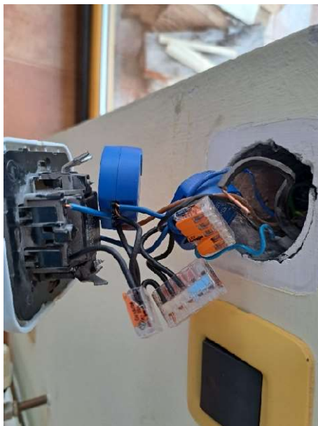
Slika 12: Končna vezava relejev na stikalo
