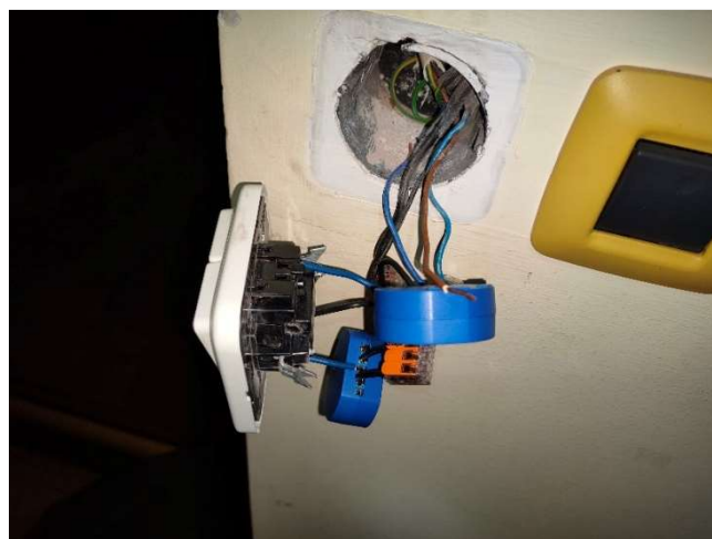
Slika 11: Vezava dveh relejev
