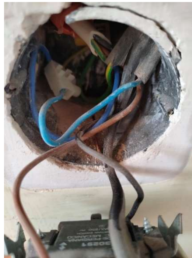
Slika 10: Vodniki za stikalom
