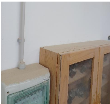
Slika 64: Lokacija odvzema prahu iz lesne delavnice.
