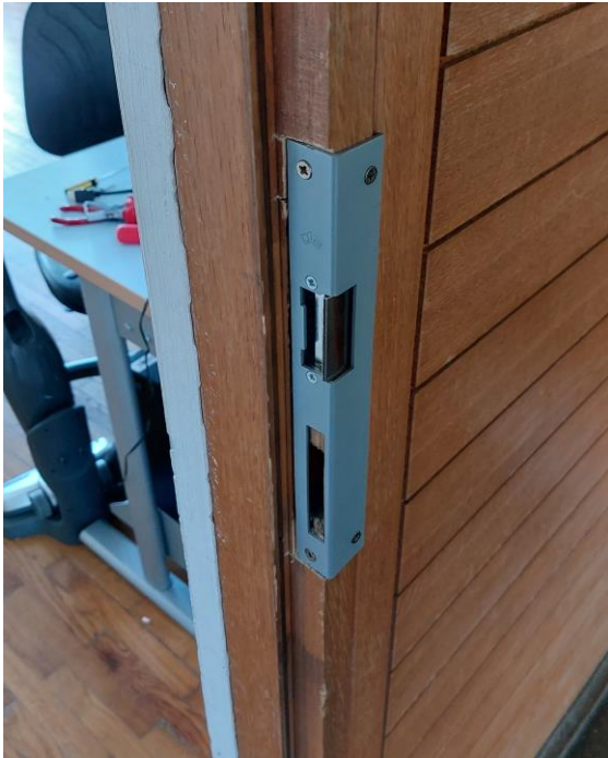
Slika 3: Električna ključavnica (Vir: lasten)
