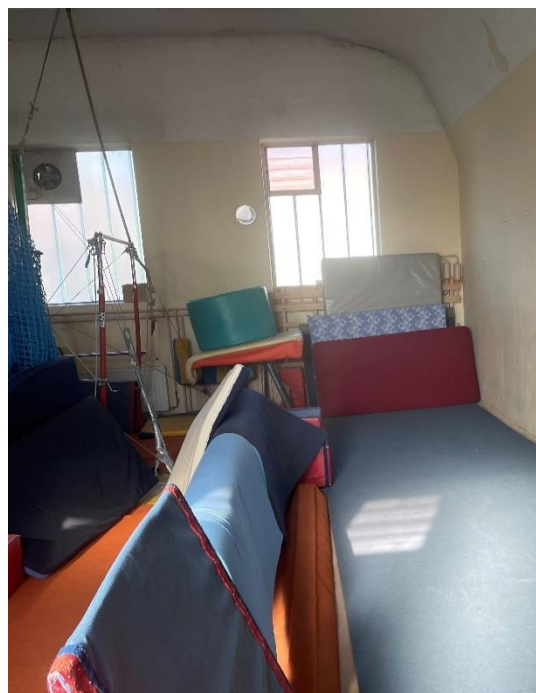
Slika 15, Obraba stropa in stene
