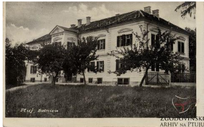
Slika 21: Bolnišnica Ptuj, ki je bila zgrajena 26. 10. 1874. (Vir: Zgodovinski arhiv na Ptuj, SI_ZAP/0219, Razglednice, AŠ 1, št. 372)
