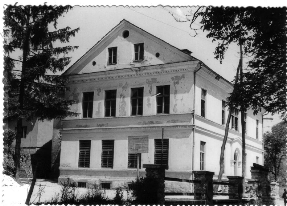
Slika 18: Šolska stavba v Šmarjeti 124 .
