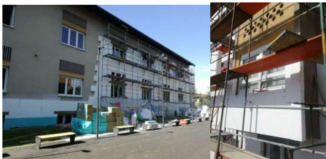
Slika 31: Izoliranje stavbe (vir: dostopno na, https://we.tl/t-FKmrkKwQMu , dne 5. 10. 2023) Slika 56: Izoliranje stavbe 2 (vir: dostopno na, https://we.tl/t-FKmrkKwQMu , dne 5. 10. 2023)
