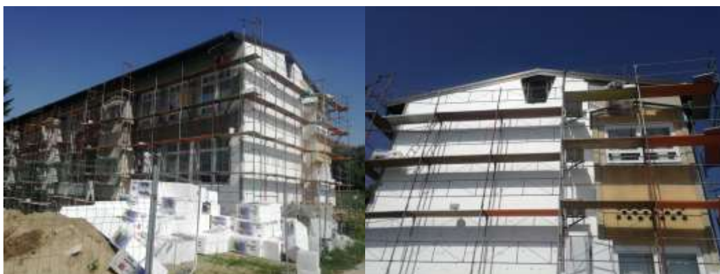
Slika 32: Izoliranje stavbe 3 (vir: dostopno na, https://we.tl/t-FKmrkKwQMu , dne 5. 10. 2023) Slika 58: Izoliranje stavbe 4 (vir: dostopno na, https://we.tl/t-FKmrkKwQMu , dne 5. 10. 2023)
