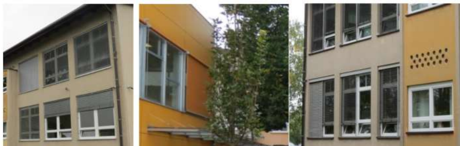
Slika 19: Primeri senčil (vir: Razširjen energetski pregled osnovne šole Draga Kobala, Maribor)
